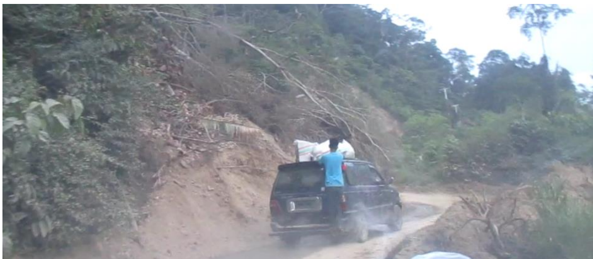
Gambar 14. Akses jalan menuju Kecamatan Kulawi yang terkena longsor
