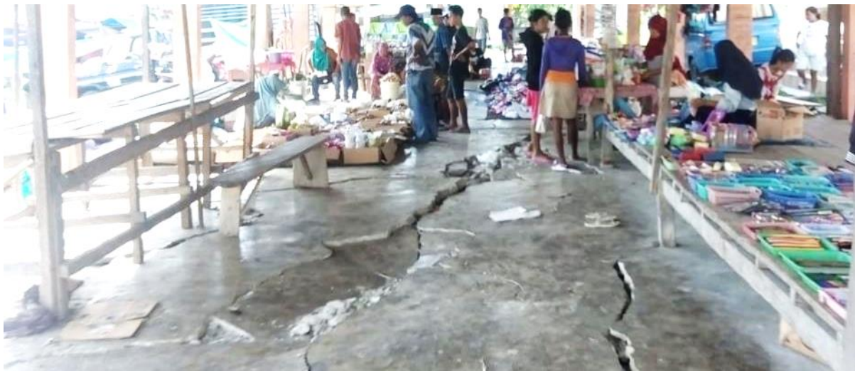
Gambar 13. Kondisi kerusakan bangunan Pasar Sambo, Kecamatan Dolo Selatan
