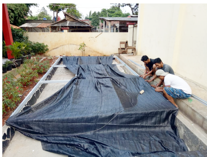
Para pekerja memasang paranet untuk Greenhouse
